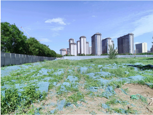
项目内土地平整情况
