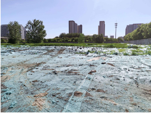
项目内土地平整情况
